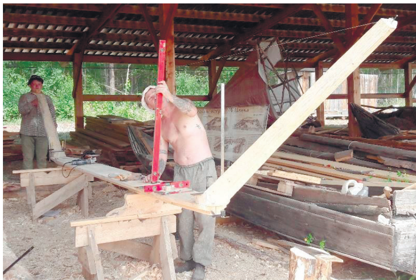
Рис. 2. Подгонка штевней к дённой (формирование каркаса)
